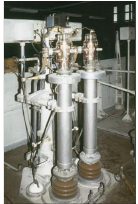
Die beiden Röhren der Gegentaktendstufe des 250-kW-MW-Senders in Burg bei Magdeburg, vgl. a. [6] Fotos: G. Klawitter (3)
